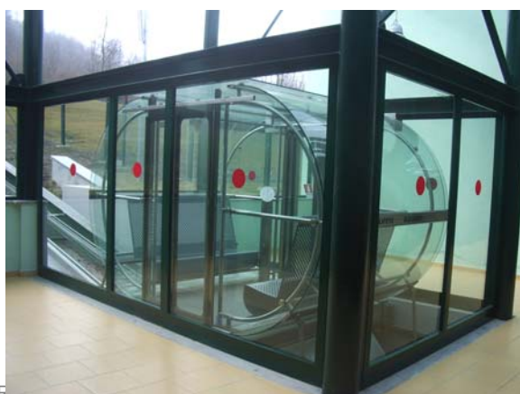
ASCENSORE DI RISALITA
